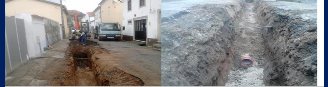
Fig. 78 – Fins dos trabalhos na conduta desta rua.
