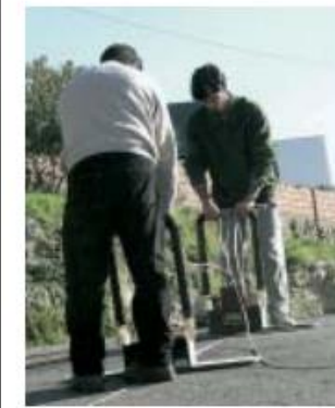
Fig. 5 Antenas de 100 MHz não blindadas do PulseEKKO IV (Sensors&Software).
